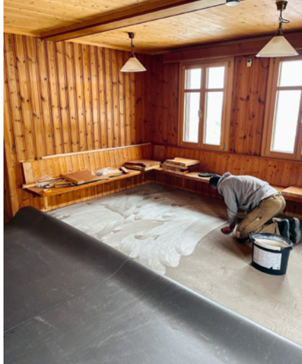
Neuer Bodenbelag im Haupthaus
