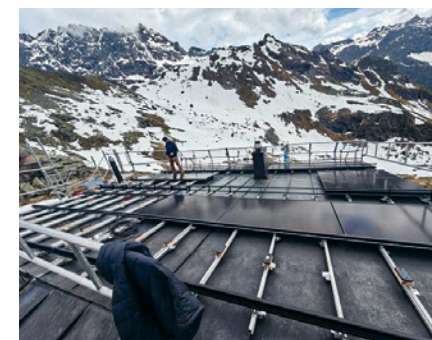
Installation der Photovoltaikanlage auf der Silvrettahütte
