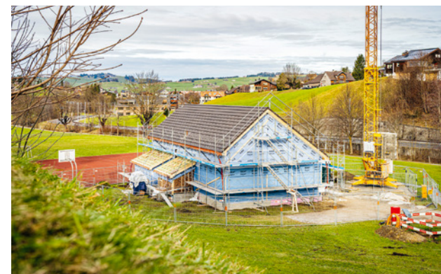
Neues Depot in Schwende im Rohbau. Bild: Carmen Wüst
